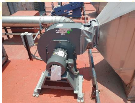
Sustitución de 9 extractores nuevos en Edificio E a los más necesitados y dañados.
