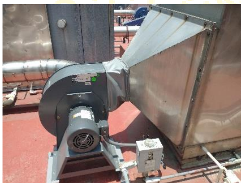
Sustitución de 9 extractores nuevos en Edificio E a los más necesitados y dañados.
